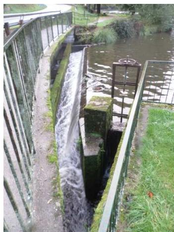
*L'ouvrage à l'aval de l'étang (à gauche) et le vannage de décharge sur le bief (à droite)*
